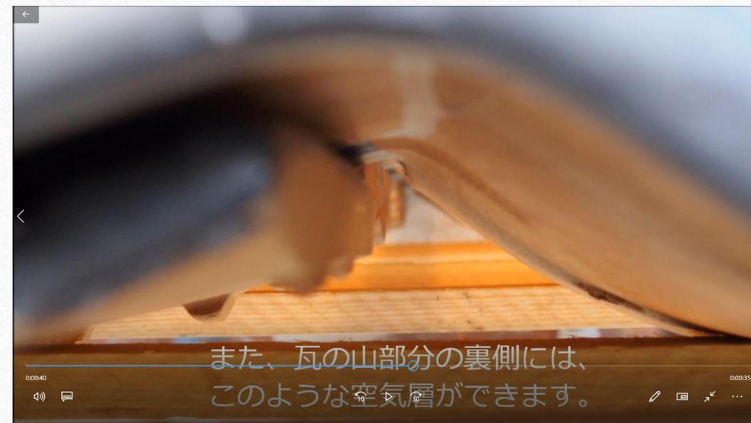
J形瓦の空気層の様子(栈山裏 縦方向)
