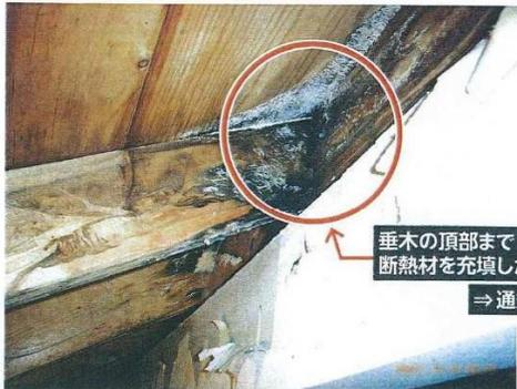
垂木の頂部まで断熱材を充填した痕跡
